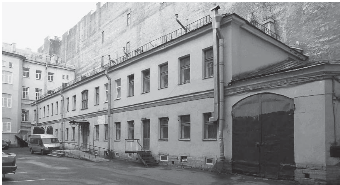
Надворный флигель по адресу: Литейный пр., д. 44, квартира № 8. Здесь РАО располагалось с 1894 по 1919 г. Съемка В. В. Лаврова. 15.10. 2014
